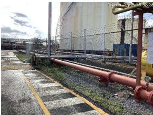
ภาพที่ 2-5 คันคอนกรีตสูง 1.00 เมตร ล้อมรอบลานถังเก็บน้ำมัน
