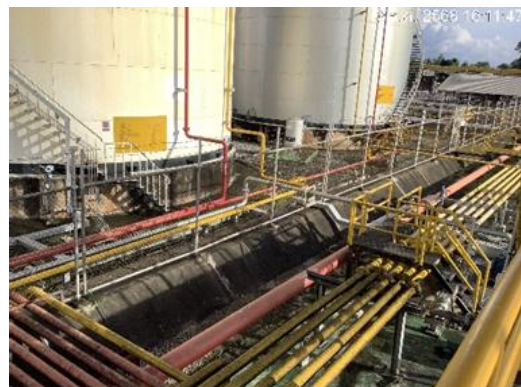
ภาพที่ 2-5 คันคอนกรีตสูง 1.00 เมตร ล้อมรอบลานถังเก็บน้ำมัน
